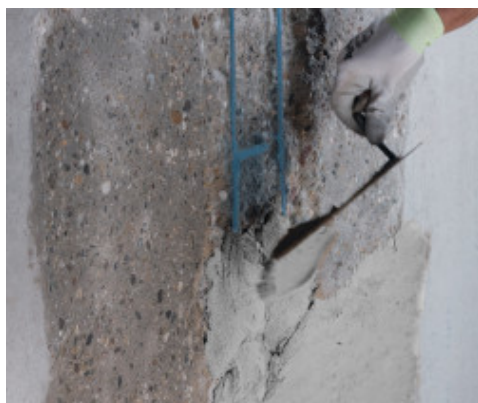
Applicazione a cazzuola di Planitop Rasa & Ripara
