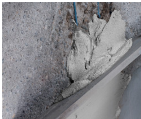
Staggiatura di Planitop Rasa & Ripara
