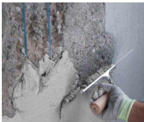
Applicazione a spatola di Planitop Rasa & Ripara
