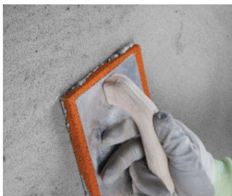
Frattazzatura di Planitop Rasa & Ripara
