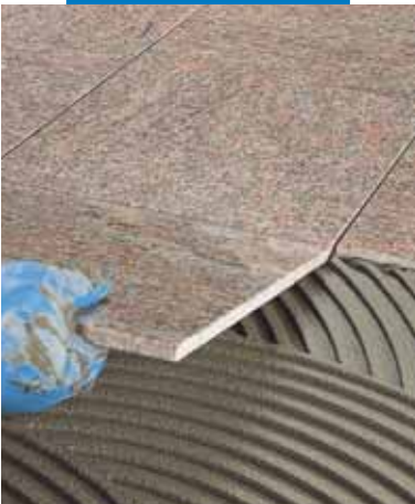
Posa di marmo prelevigato a pavimento
