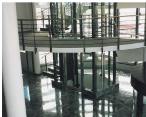
Pavimentazione in marmo verde Alpi realizzata nella hall di ingresso della Rolex (Bienne - Svizzera)
